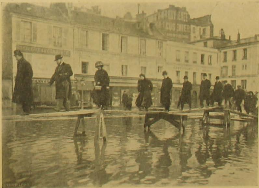
Regtönzött gyaloghíd a rue de Passyban.
