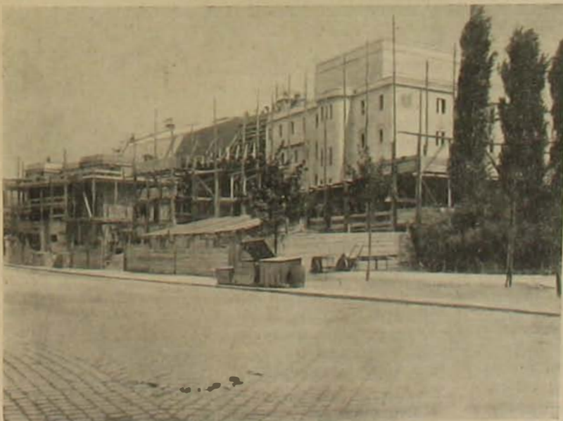
A budapesti új Néopera építkezése. — Külső részlet.
