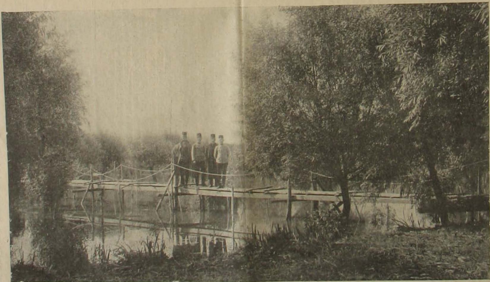
A Vág-Duna árterületén épített 53 méter hosszú gyalog bürü, háromnegyed óra alatt építette 22 honvéd.
