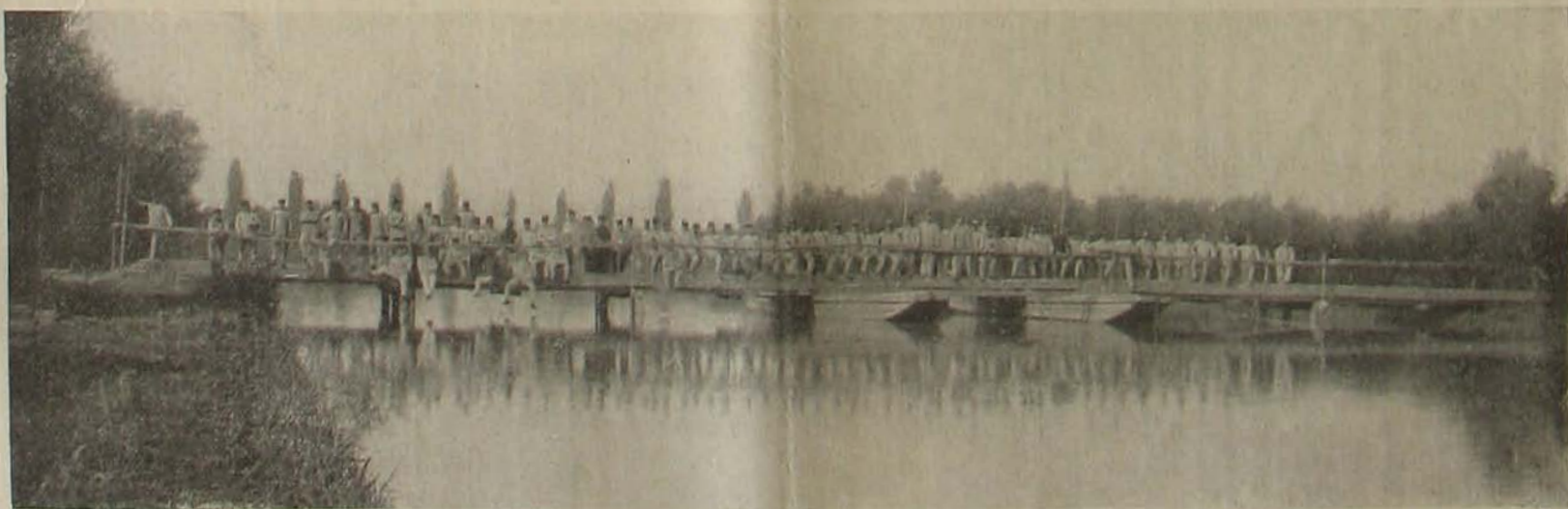
A Nyíráni keresztül épített hid. Hossza 36 m. Készítette 60 honvéd két és egynegyed óra alatt.
