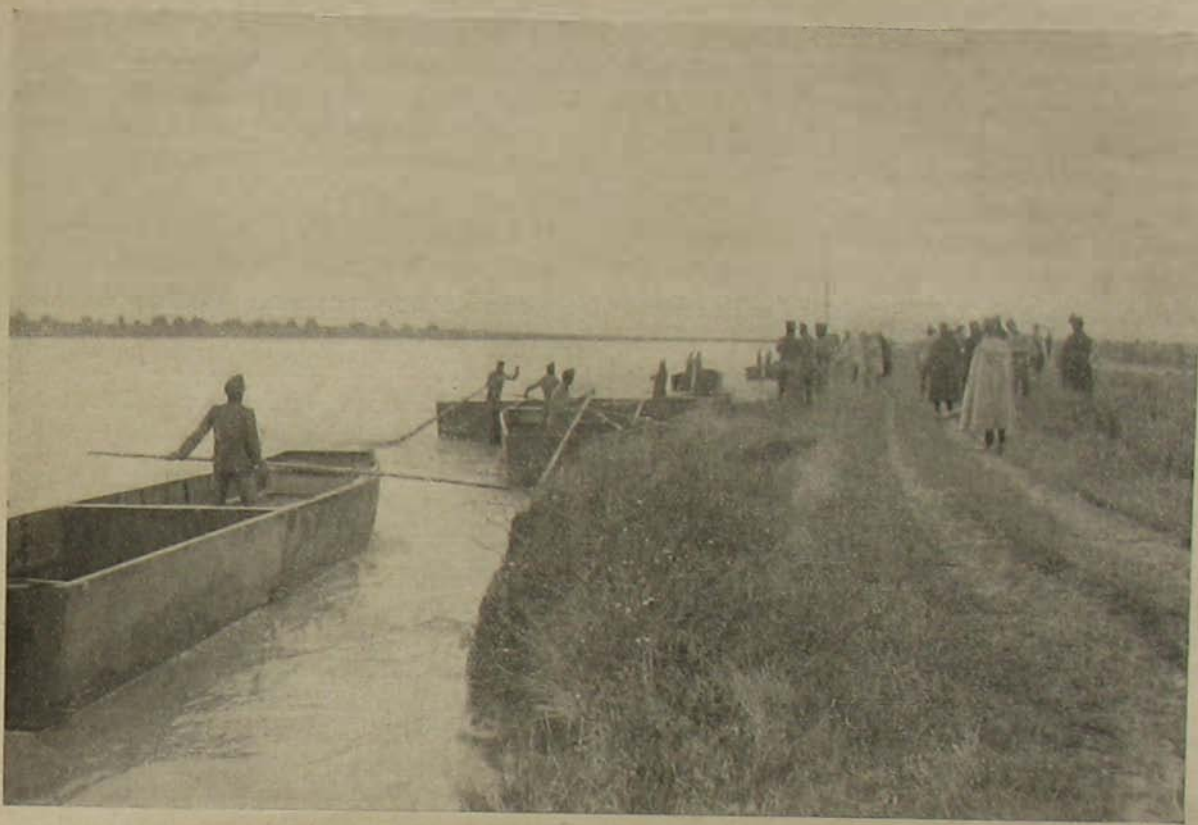
Az utászcsapatok a pontonokat a hidépítéshez felvontatják.
