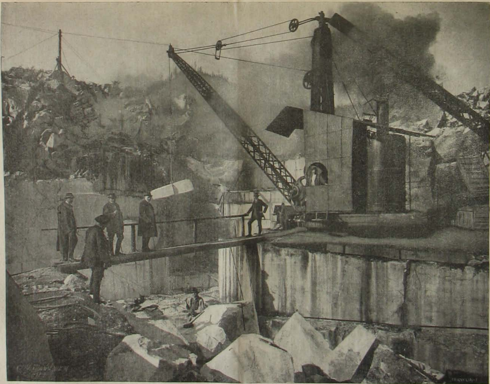
Márványtömbök szállítása emelő-daruval a ruskiezabányai márványbányában.
