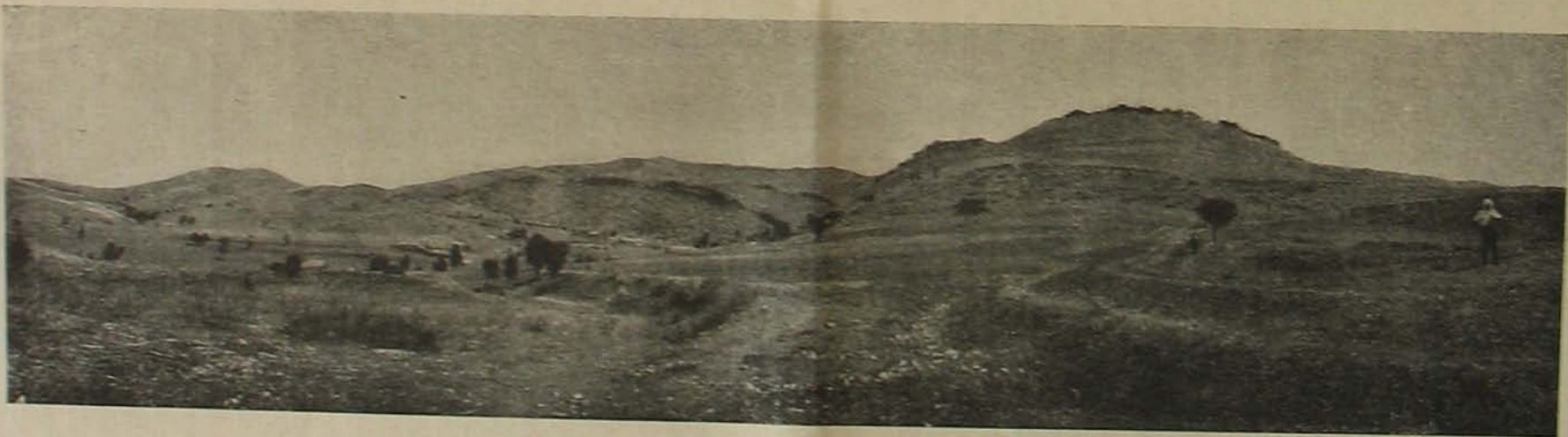
A carevoselói-út Őrnikamennánál.
