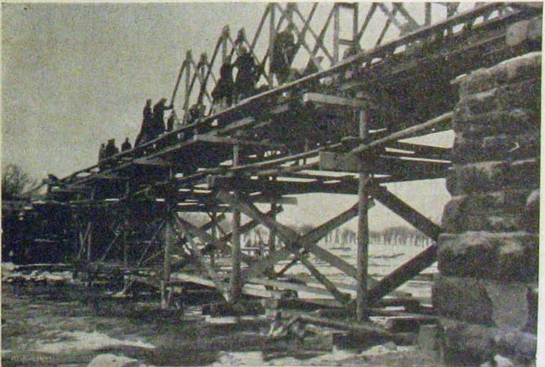
Hídászatok munkában. — Az oroszok által megrongált hidakat helyreállítják vagy újakat építenek.
