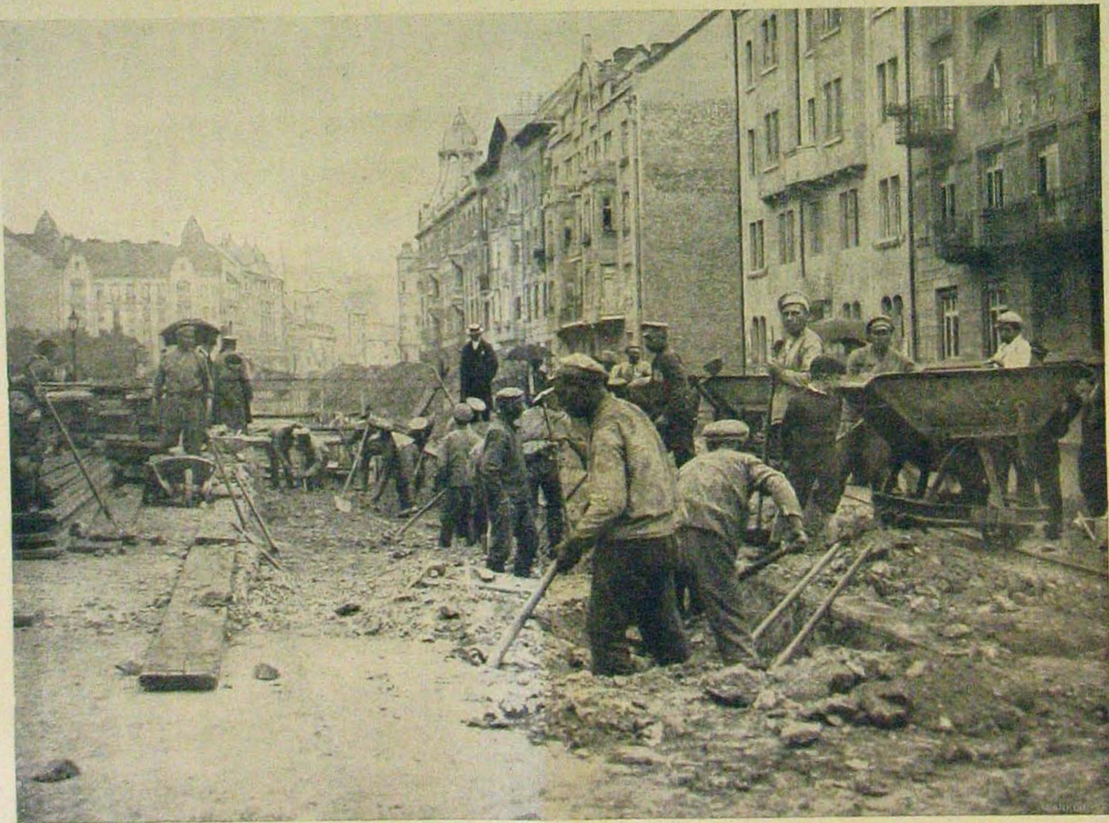
Orosz foglyok Budapesten, a villányi-úti csatornát építik.
