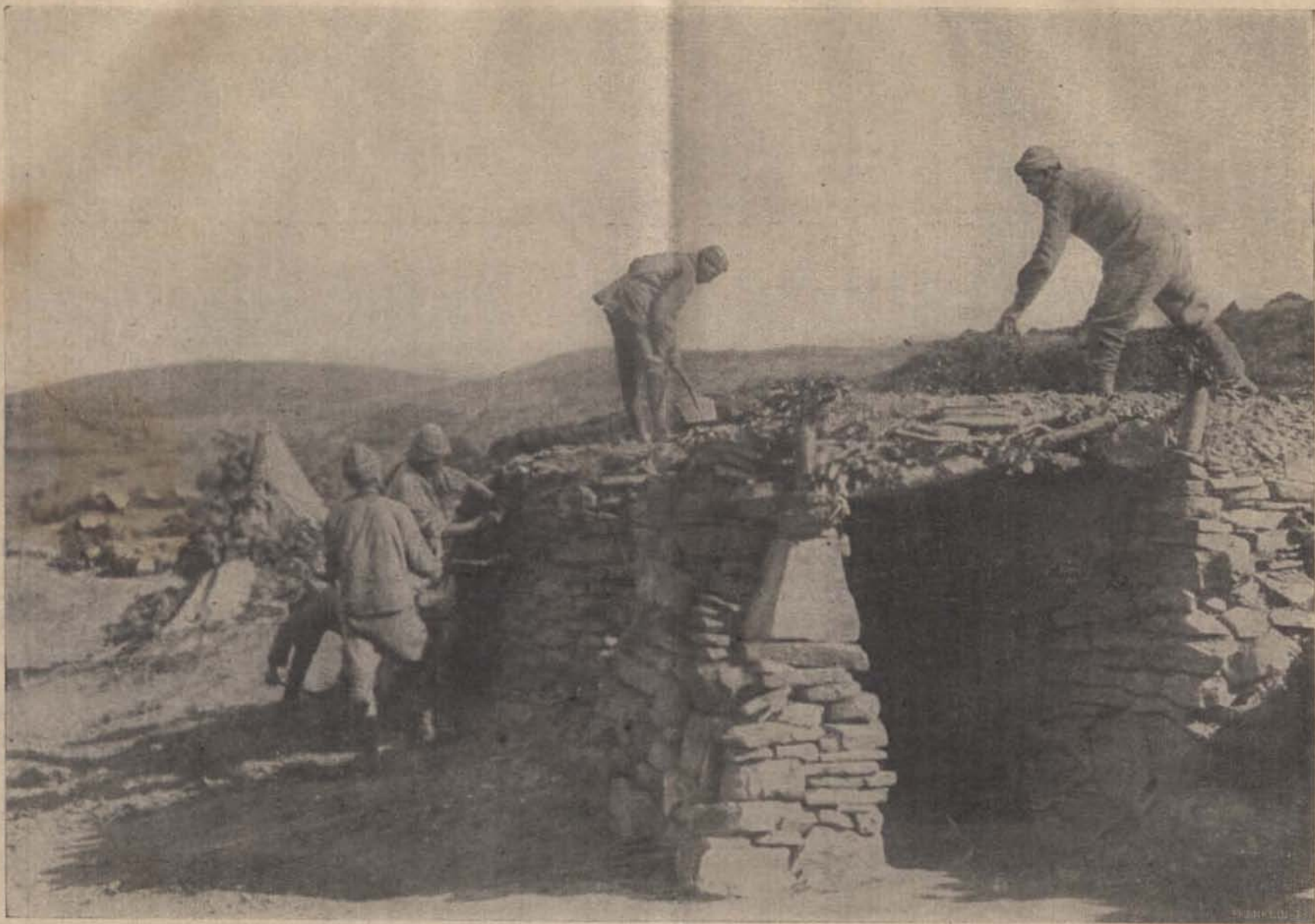
A gallipolii harcokból. — Épülő fedezékek.
