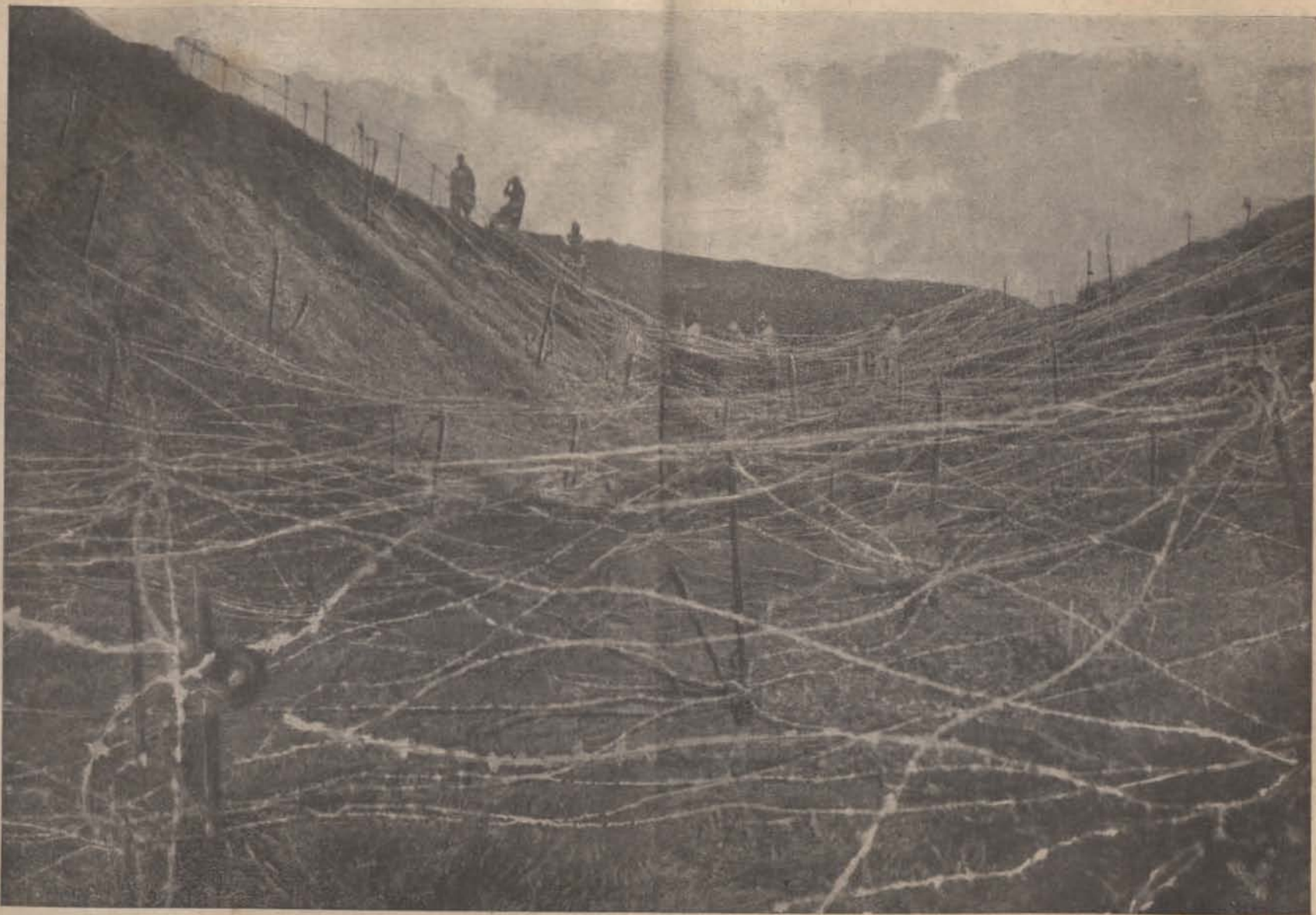
Drótakadályok Szaloniki vidékén.
