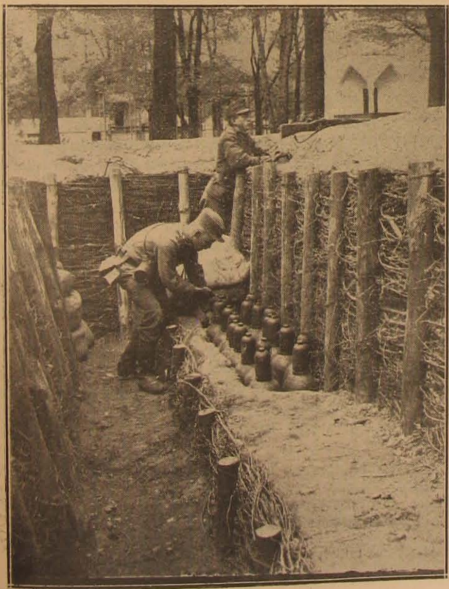
3. ábra: Gázpalackok beépítése.
