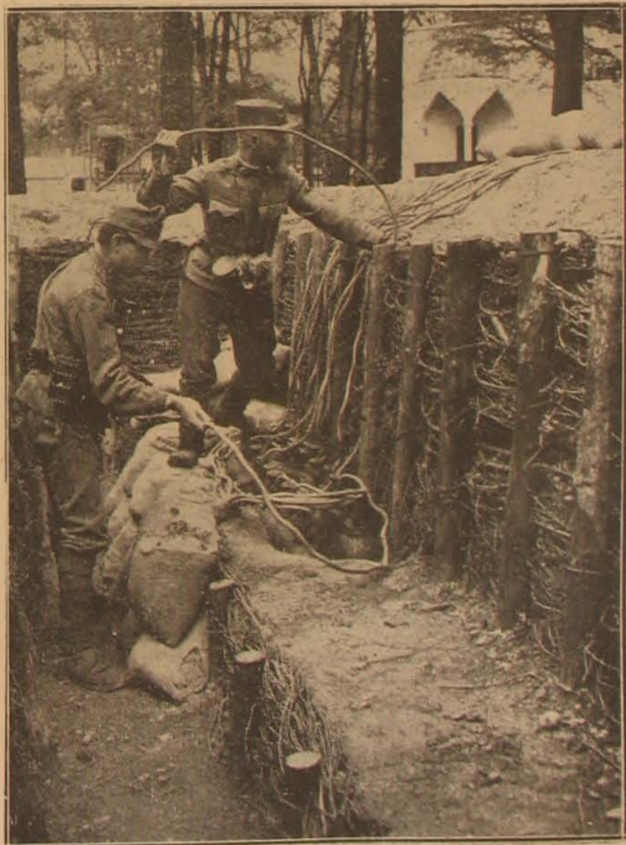
5. ábra A gázpalackok ólomcsöveinek átvezetése a mellvéden
