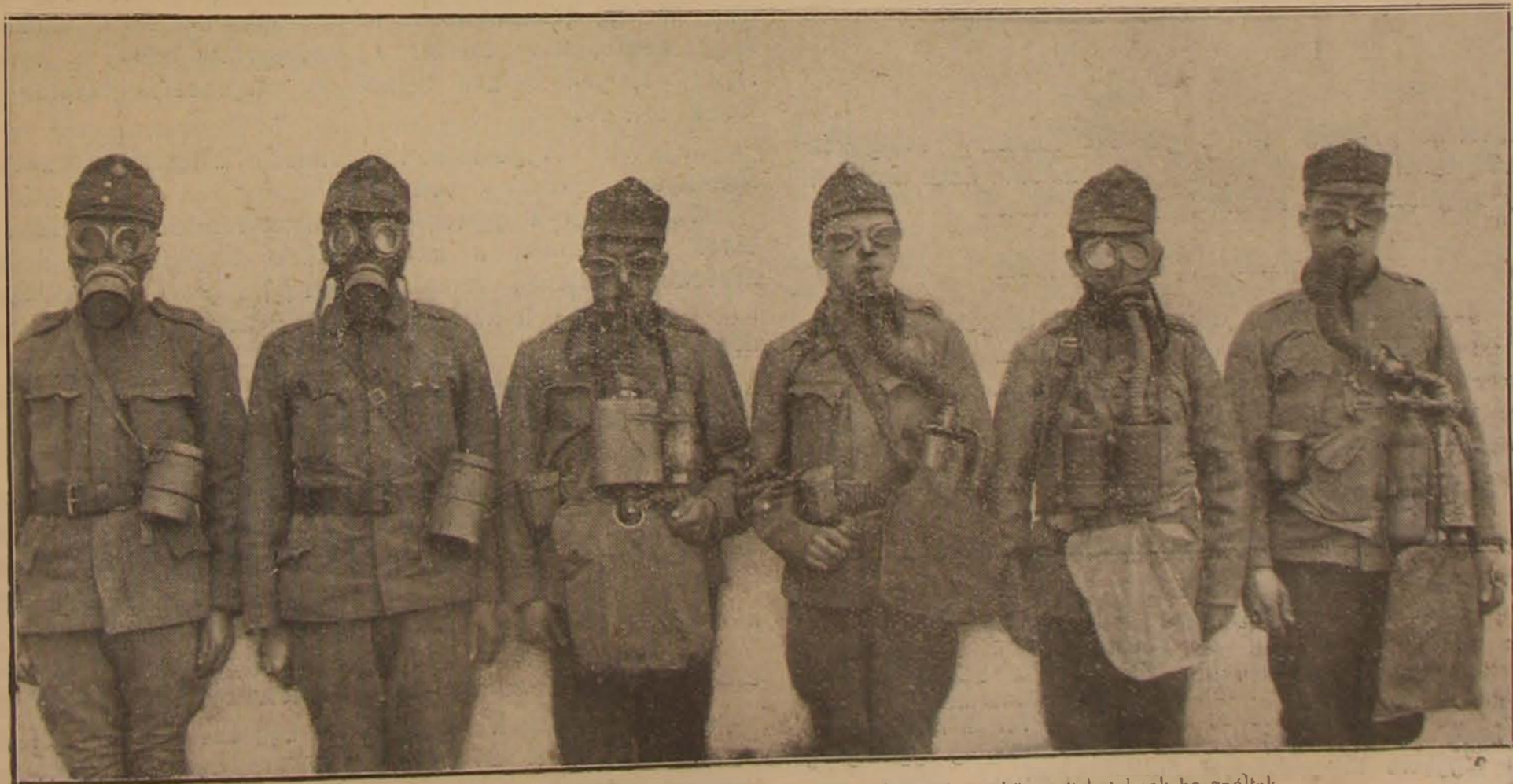
11. ábra. Oxigénfejlesztő, u. n. önmentő készülék, melyeket a háboru alatt a központi hatalmak használtak.
