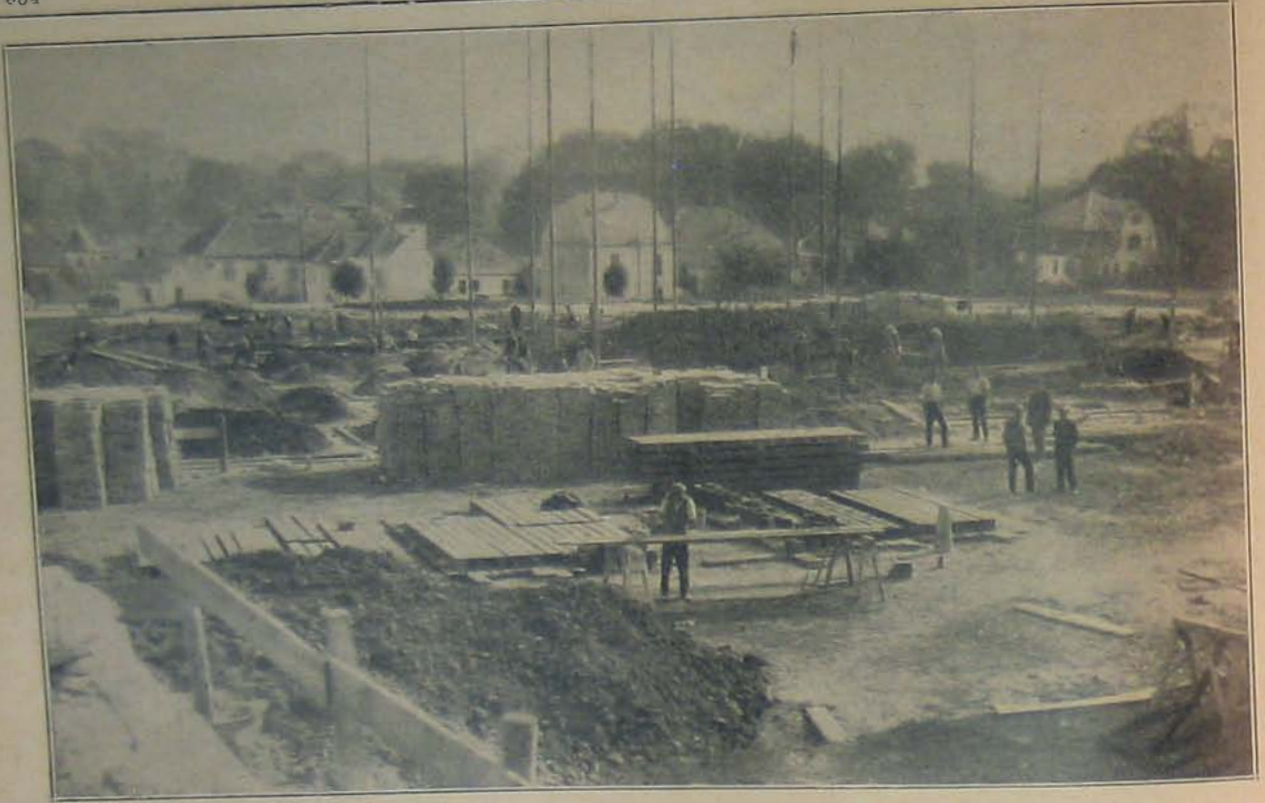
Szeptember 20-án indult meg az új hévízi csendőrotthon építkezése.
