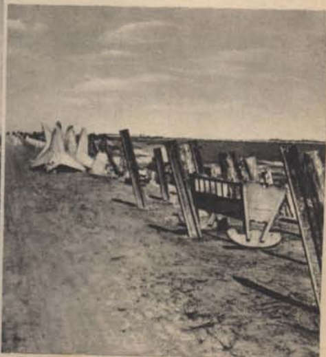
Az akadályok közé bölcsőt is tettek.
