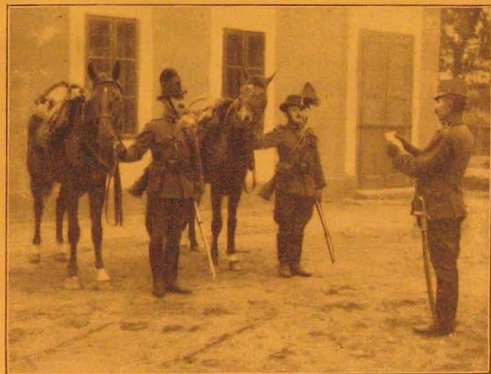
Abfertigung einer berittenen Patrouille.
